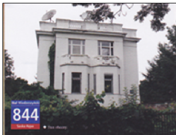
Przedwojenna willa przy Wale Miedzeszyńskim – zachodni skraj umocnień Barykady
