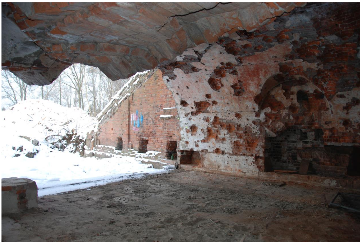
Fort Piłsudskiego – kazamaty przygotowane do adaptacji
